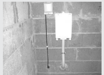
Montierter Hausanschlusskasten
